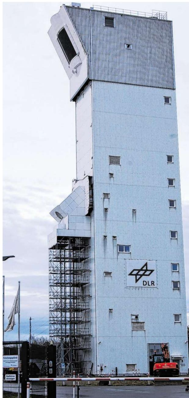
Das Solarturm-Kraftwerk hat im Moment zwei Receiver, durch die heiße Luft (oben) und heiße Partikel (Mitte) eingeleitet werden. Die Messkampagne dauert noch bis Mai. Fotos: Uerlings
